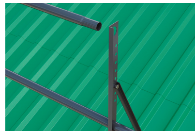
Рис.3 В отверстия диаметром 27 мм, установить горизонтальные трубы, служащие поручнями.
